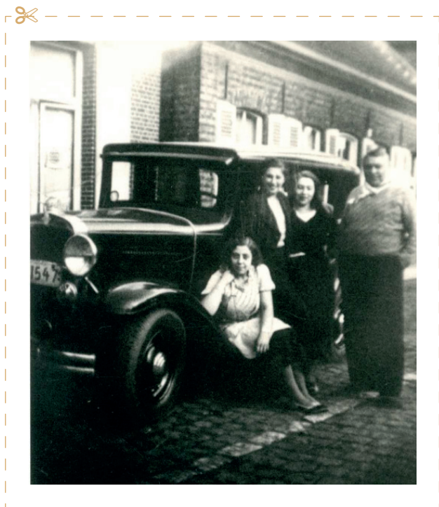
▼ Vervoer: De auto van het gezin Ferdinand Schaevers - Van Genechten in de Steegstraat. (Foto Erfgoed Balen – EGB_015859)
